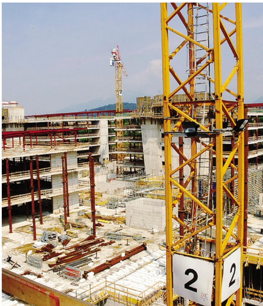
Il cantiere del Papa Giovanni nell'estate del 2007
