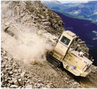
Un mezzo da scavo di Tesmec
