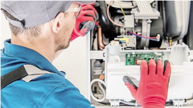
Un tecnico caldaista durante un controllo di un impianto
